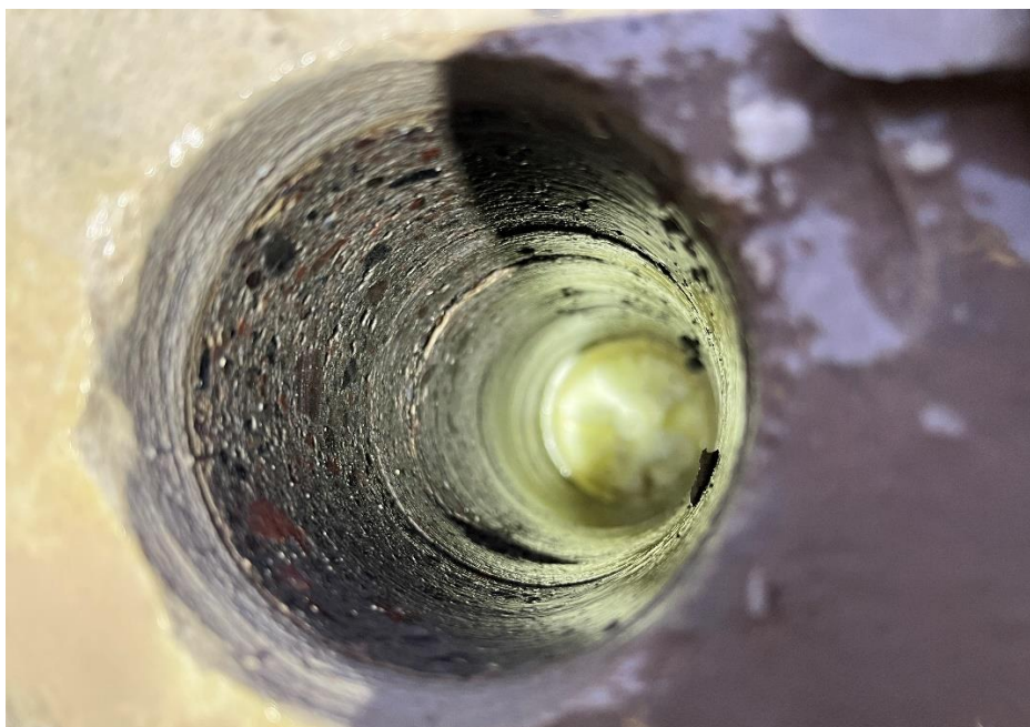
Kuva on otettu porrastasanteelta, lieriöreiän pohjalla näkyy alapuoleisen tilan katon lämmöneriste.
