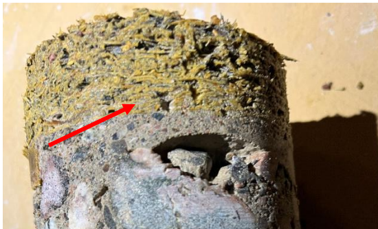
Kuva 3. ASB.03, liikuntasalin alapuoleisten tilojen katon äänieristyslevy (toja) ja sen kiinnitysmateriaali
