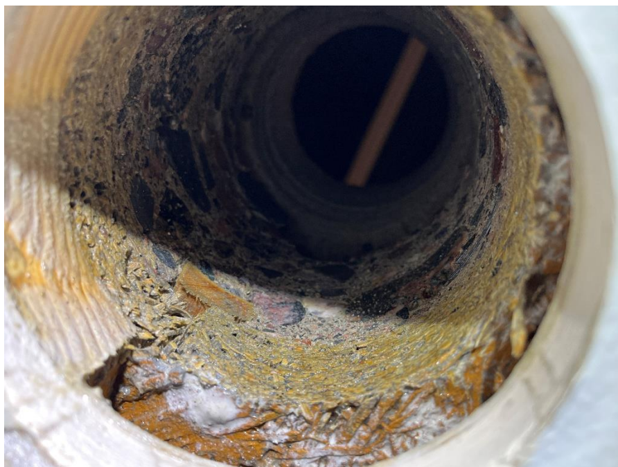
Kuva on otettu liikuntasalin alapuolisesta tilasta ylöspäin läpirakenteen poratusta reiästä.
