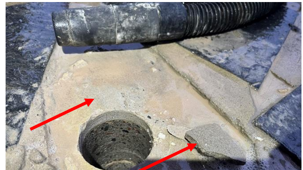
Kuva 4. ASB.04, Ulkoporrastasanteen kivilaatan kiinnityslaasti + saumalaasti
